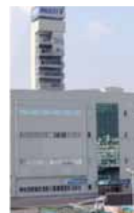
Test di affidabilità con strutture ad elevata lunghezza tubazioni ed elevazione
